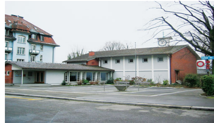
Kirche Letten Imfeldstrasse 51 8037 Zürich
